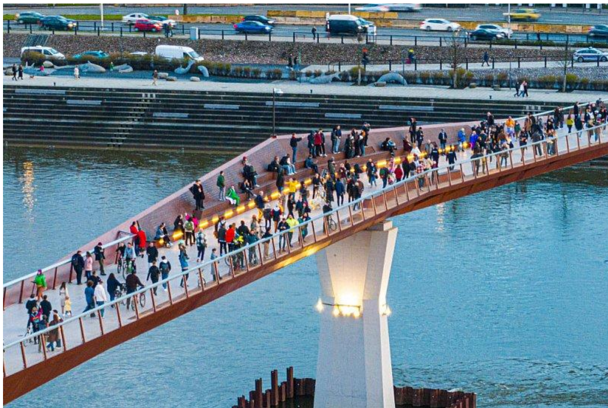
Fotografia 5.5 Kładka pieszo-rowerowa na Ursynowie w Warszawie
