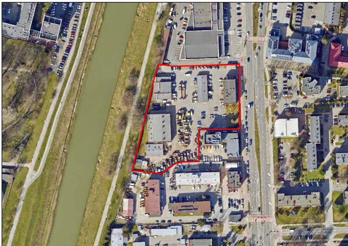
Rys. Aktualny stan zagospodarowania terenu [ObliView Rzeszów]
