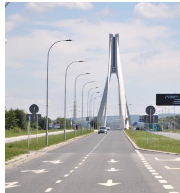
Elementy infrastruktury komunikacyjnej
